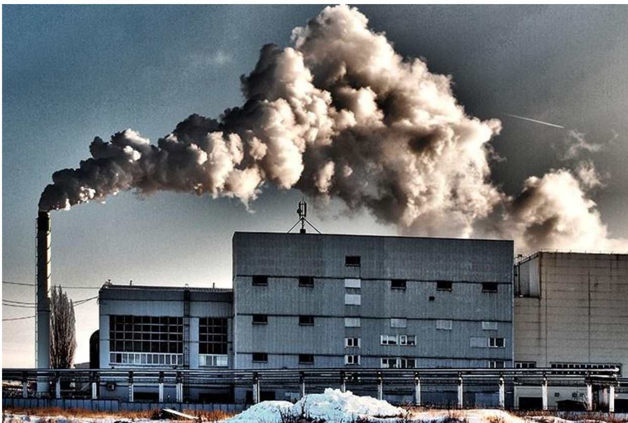
Мусорозжигательный завод: (Фото 5)
